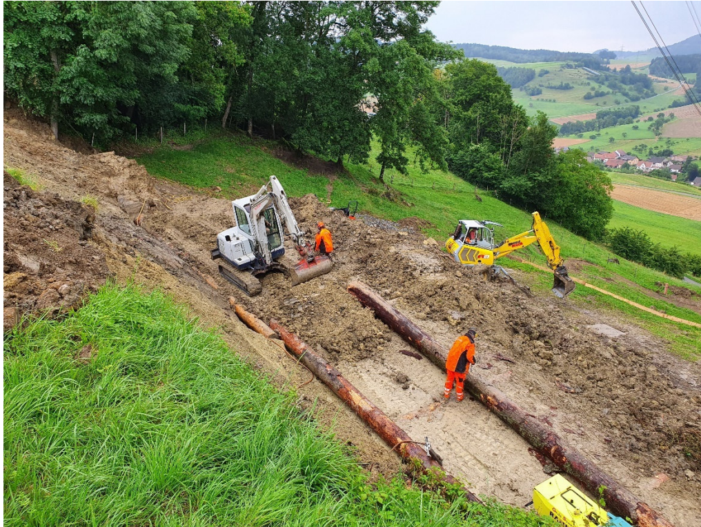
Abbildung 5 Hangsanierung Voregg mit einem Holzkasten
