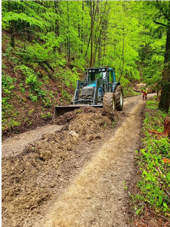
Abbildung 2 Abranden von Waldstrassen mit dem Valtra
